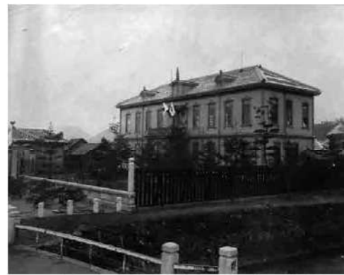
四国水力電気株式会社本社 大正3年頃 多度津町蔵
