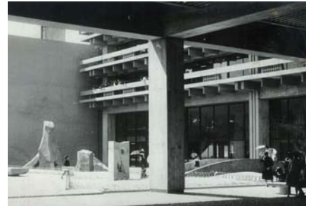
竣工した香川県庁舎南庭と庭石
