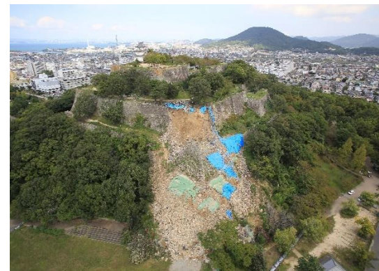
国指定史跡「丸亀城跡」(修理)
