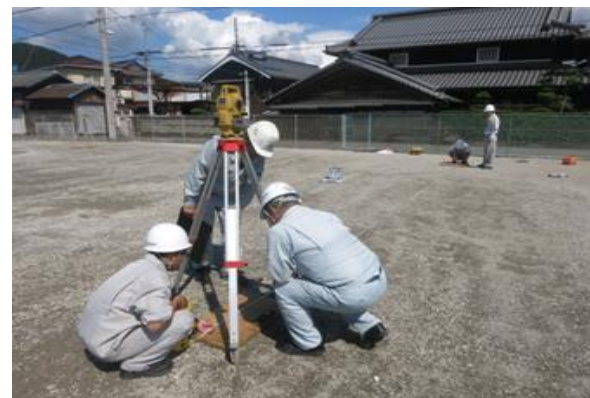
建設工事現場でのインターンシップ
