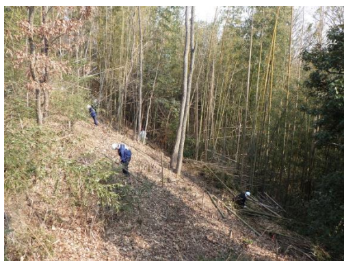
<竹を伐採して、植林する場所を整備します>
