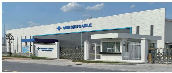
ベトナム第2工場
