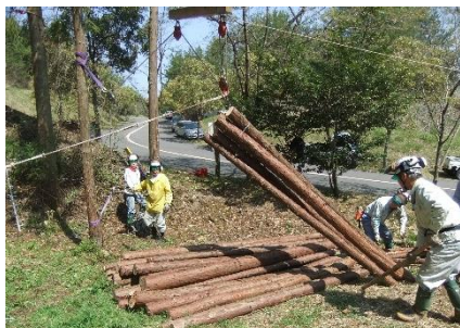
(伐採作業の様子)
