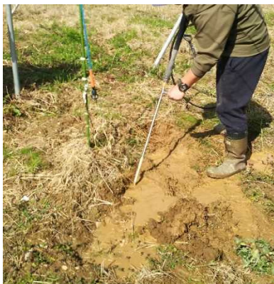
掘削する様子
