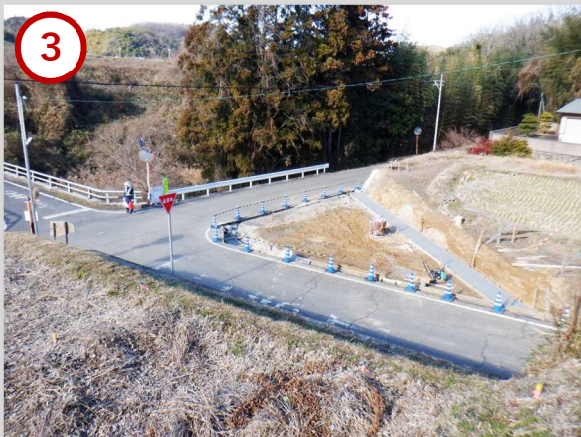
平成橋の東側交差点を、車両のすれ違いがスムーズにできるよう、一部隅切りも行っています。 工期：R5.7.11～R6.2.29 受注者：河田土建(有)
