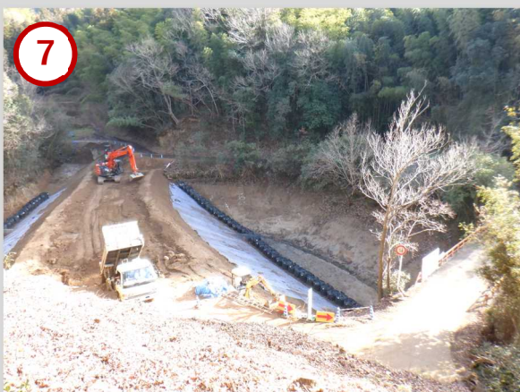
既設の橋に重量規制（14t まで）があり、工事用車両が通行できないため、代わりの工事用道路を貯水池内につくっています。 工期：R5.9.12～R6.2.15 受注者：綾上建設(株)
