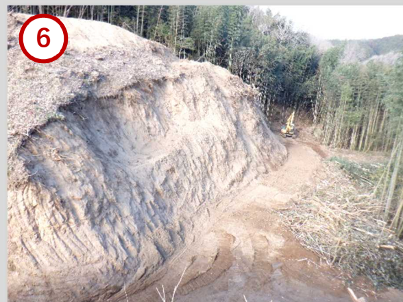
付替道路工事を施工するために必要な、進入路の設置や樹木の伐採を行っています。 工期：R5.8.23～R6.2.29 受注者：桑島開発(株)
