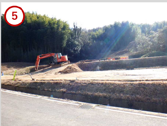
付替道路工事を施工するために必要な、進入路の設置や樹木の伐採を行っています。 工期：R5.7.11～R6.2.29 受注者：河田土建(有)
