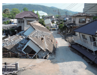
熊本地震の被害
