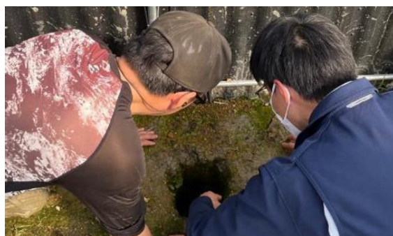
縦穴をのぞき込み地下水位を確認
