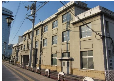
解体直前に撮影された高松港管理事務所 (平成24年 撮影)
