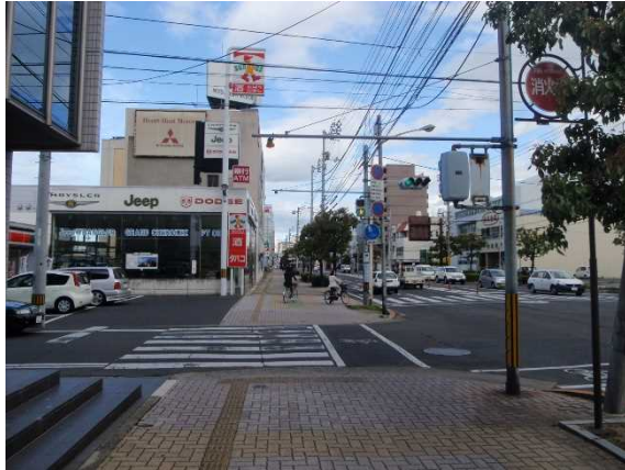
電線共同溝（整備前）
