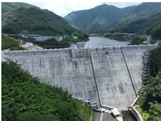
栂川ダム（ダム正面）
