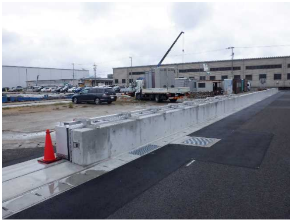
高松港朝日地区
