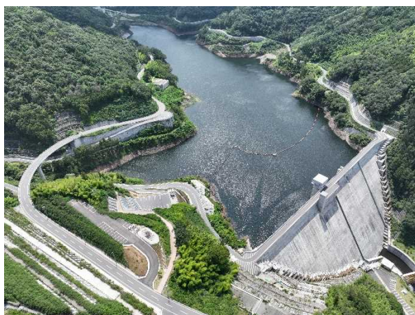
栂川ダム（貯水池全景）
