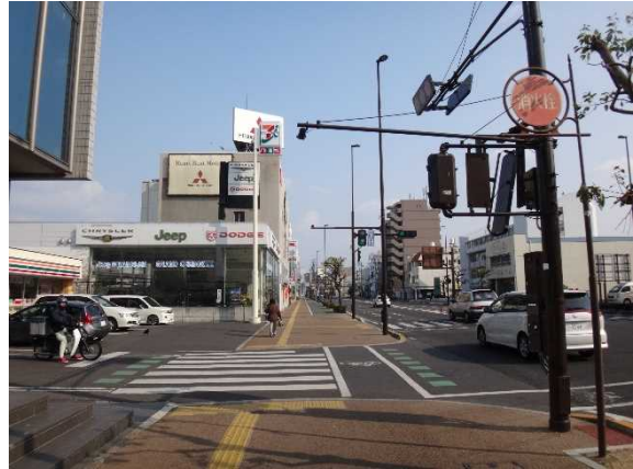
電線共同溝（整備後）
