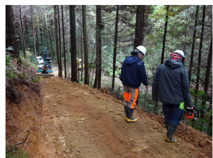
⑨ 排水や盛土法面の指導
