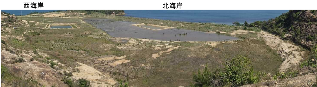
写真1 豊島処分地（東側から撮影）
