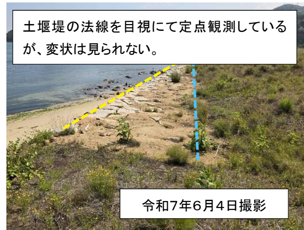
写真5 土堰堤（被覆石の法線を基準に、土堰堤の法尻法線を目視にて定点観測：変状なし）
