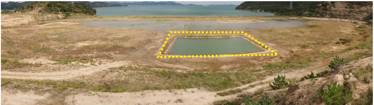
写真 2 浸透池㉕の周辺状況 (R06.11.5 南側から撮影)
