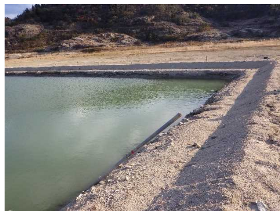
写真5 完了確認時の浸透池⑯の状況
