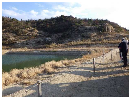
写真7 完了確認時の浸透池⑮の状況
