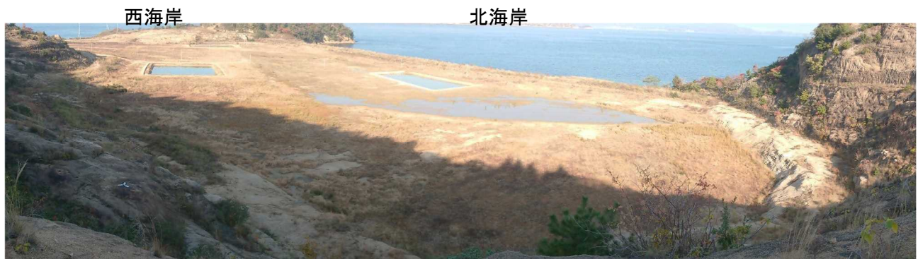
写真 1 豊島処分地（東側から撮影）
