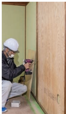
構造用合板の取付状況
