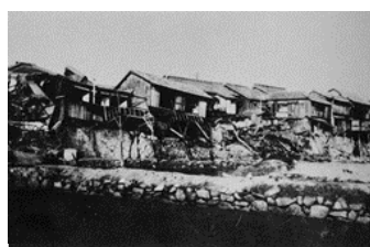
(昭和 21 年 南海地震による被害)
