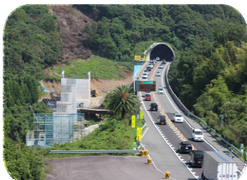
(東かがわ市：四国横断自動車道)
