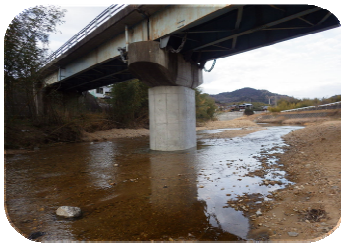
(さぬき市：寺尾橋)
