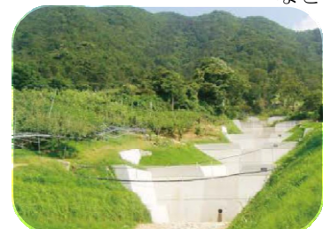
(観音寺市：治山ダム)
