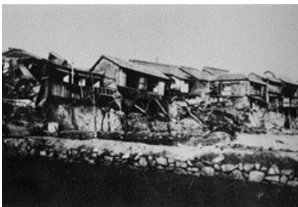
(昭和21年 南海地震による被害) (坂出市)
