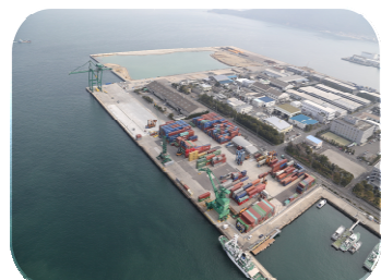
(高松市：高松港コンテナターミナル)
