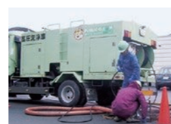
高圧洗浄作業
