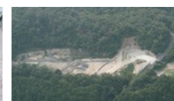
最終処分場 (安定型埋立地)
