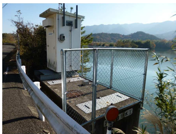
香川用水宮奥池分水工
