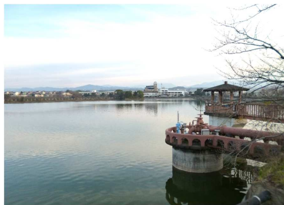
取水塔側から御旅所を望む
