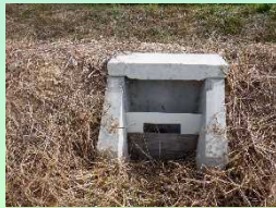
せき板設置状況
