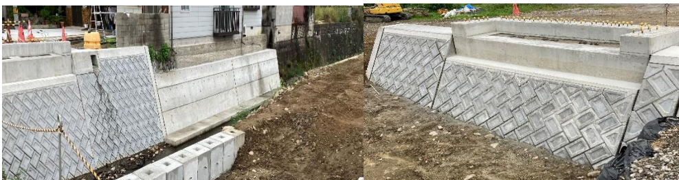
河川拡幅工事にもなう橋梁架け替えのための橋梁下部(兩岸)工事
