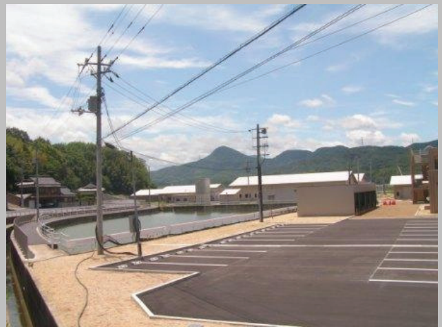
調整池・駐車場
