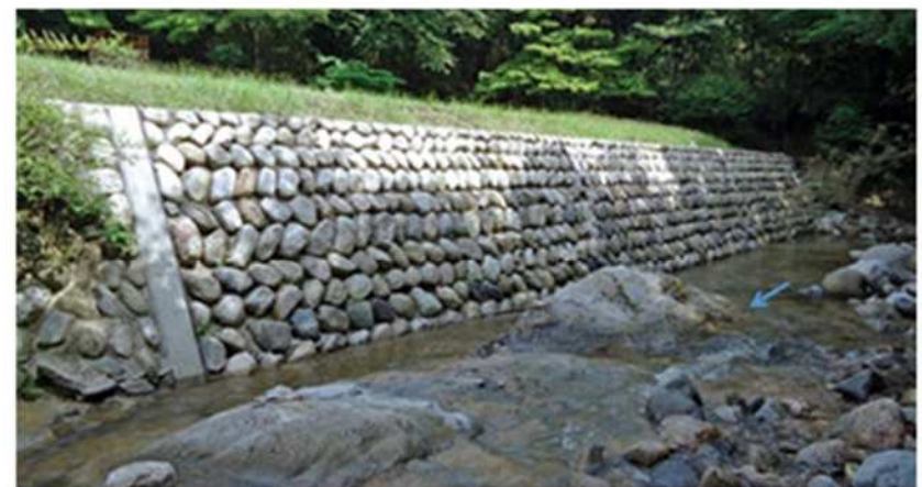
被災施設を原形に復旧
