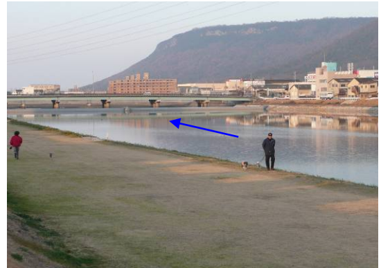
春日川下流域高水敷(潮止堰上流付近)
