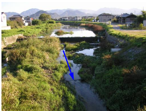
新川上流 福万大橋から上流を望む (河口から 12.3km 付近)
