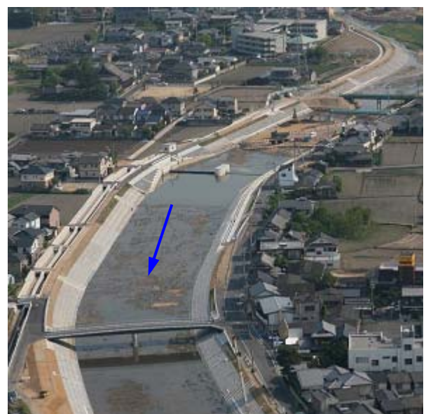
河川整備状況 春日川 かわくぼし 川久保橋上流(合流地点から 7.0km 付近)
