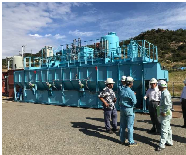
写真3 試運転時の確認の状況
