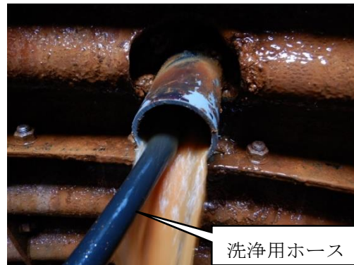
写真6 横孔洗浄状況（近景）（第4層-18）
