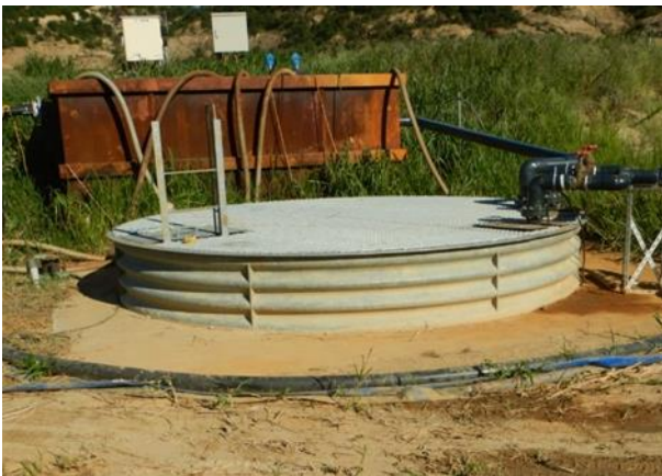
写真1 集水井の外観（R1.9.9）
