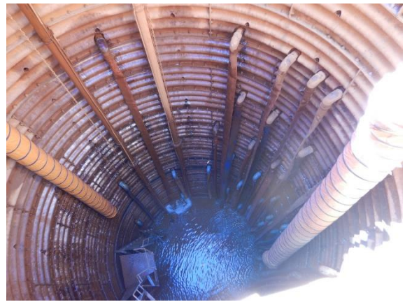
写真 2 集水井内部の状況（R1.9.9）
