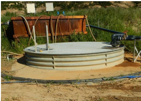
写真 1 集水井の外観（R1.9.9）
