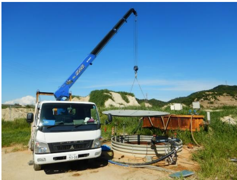
写真3 集水井蓋撤去状況
