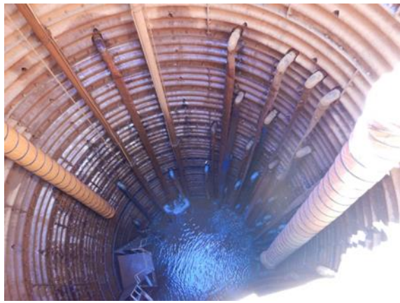
写真2 集水井内部の状況（R1.9.9）
