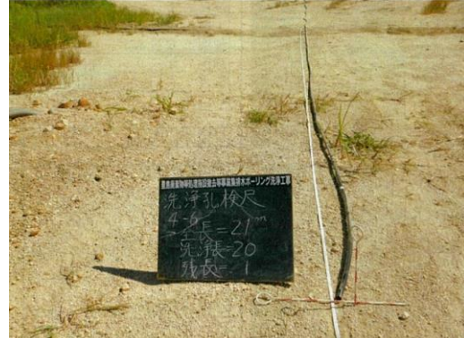
写真8 洗浄用ホースの挿入長確認
