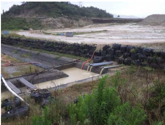
写真6 大雨時 (R1.6.15) の排水状況 (累計雨量 56.5mm、時間最大雨量 8.5mm)
