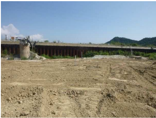
写真4 つぼ掘り拡張区画の整地状況 (北揚水井付近 (整地中))
