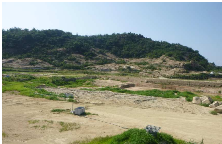
写真 3 FG34 付近の整地の状況 (R1.7.30 北から撮影)
