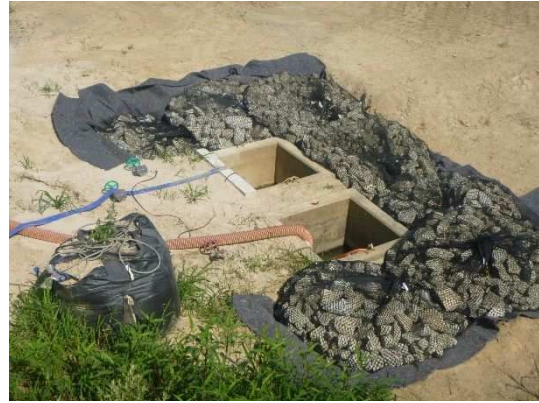
写真3 集水桝付近 土砂流入防止対策 (土砂だまり (袋詰玉石敷設) 設置)
