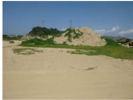
写真5 井戸側撤去後の整地状況
