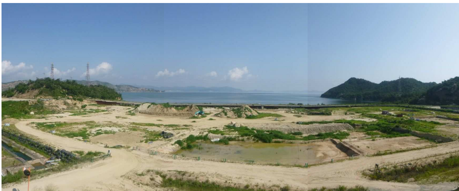
写真1 施工状況（R1.7.30）
