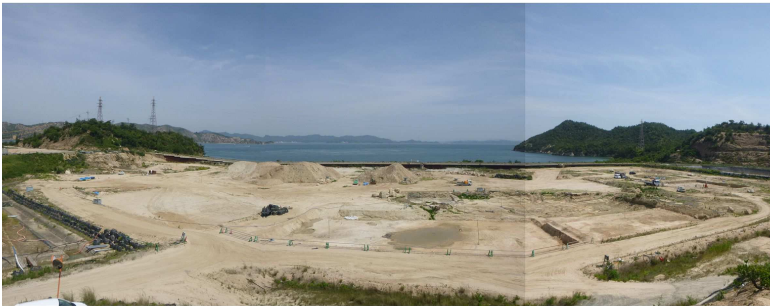
写真 1 施工状況（R1.5.30）
