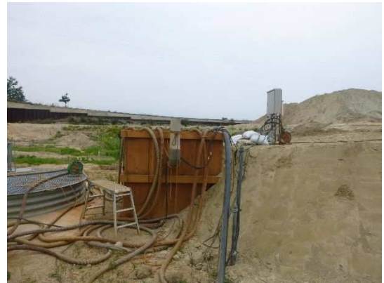
写真5 集水井の電源ボックス移設状況
