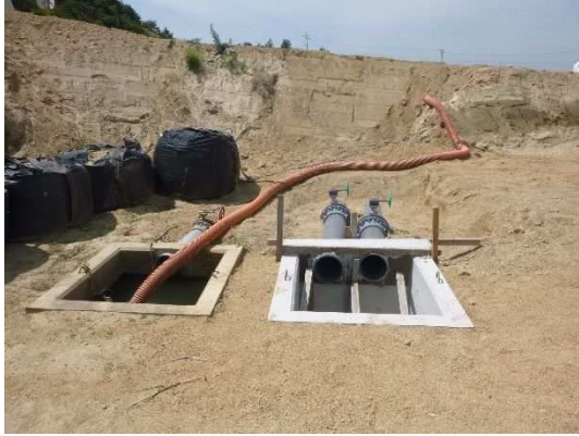
写真2 集水樹の設置状況
