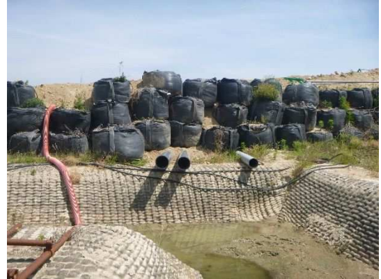
写真3 暗渠の設置状況
