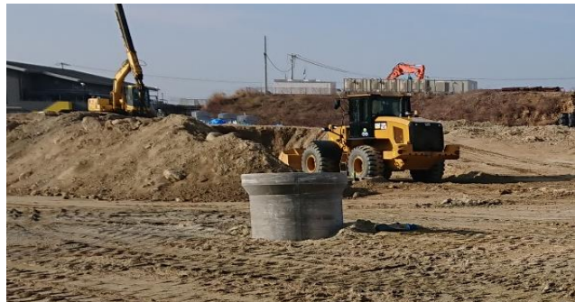
写真1 井戸側の設置状況
