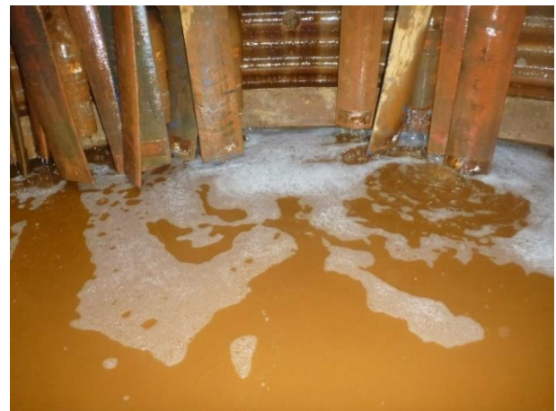
写真3 集水井底部の状況（R1.5.8）
