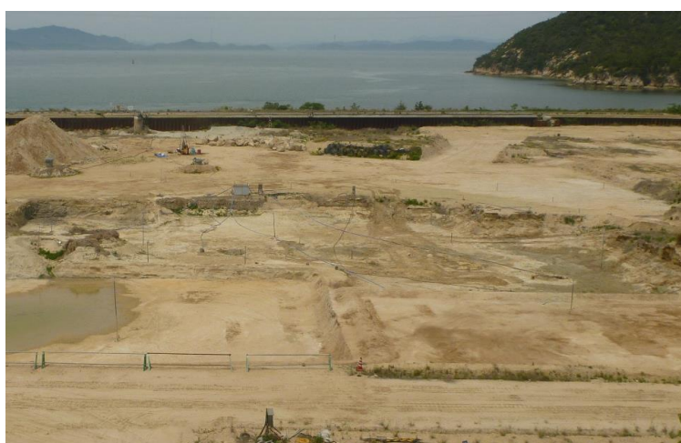
写真2 掘削区画（FG34 付近）の状況（R1.5.16 処分地南側より撮影）
