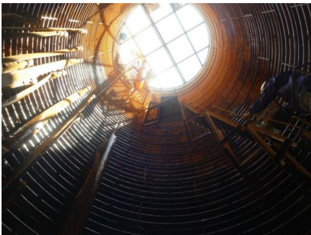
写真2 集水井内部の状況（R1.5.8）
