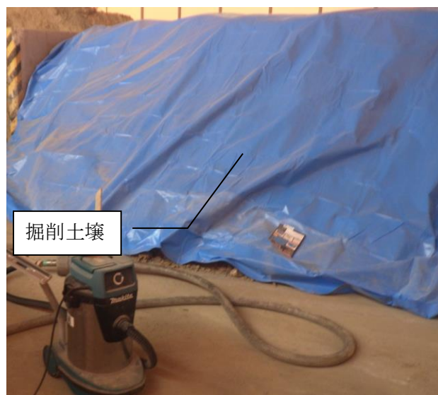
写真 1 ガス吸引の状況（H31.4.29 積替え施設 撮影）
