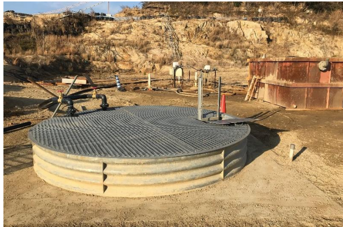
写真1 集水井の外観（H31.1.19）
