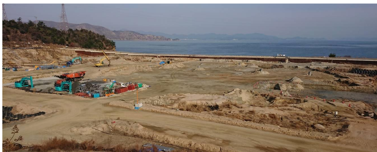
写真1 施工状況（H30.2.16撮影）
