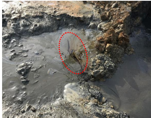
写真2 掘削（油）の状況（H30.1.31撮影）
