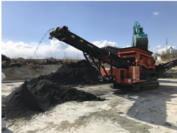
写真6 粒度調整の状況 (H30.2.14 撮影)
