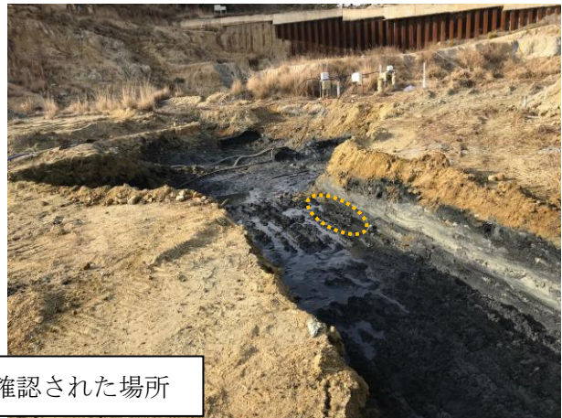
写真5 掘削の状況（H30.1.31撮影）
