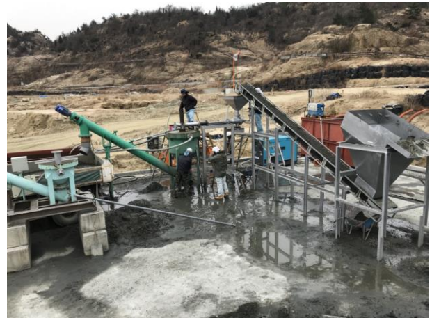
写真7 洗浄浄化の状況 (H30.2.14 撮影)
