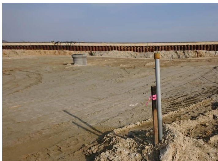
写真2 井戸側及び観測孔の設置状況
