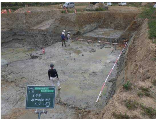
写真3 完掘時の状況（小区画⑥-7,8）
