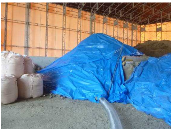
写真9 ガス吸引処理の状況
