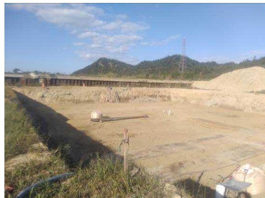
写真2 埋戻し後の状況（全景（南側から））
