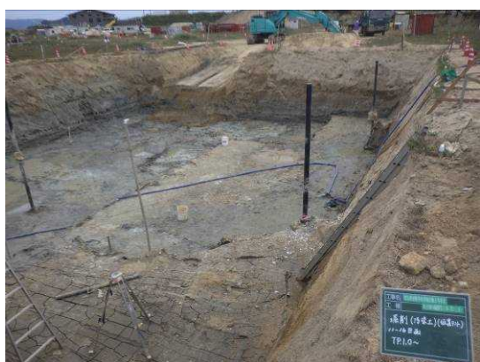
写真5 完掘時の状況 (小区画⑩-6 付近) 東側から
