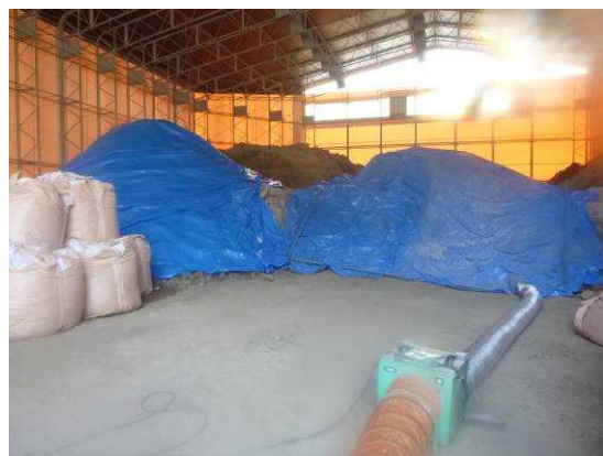
写真10 ガス吸引処理の状況
