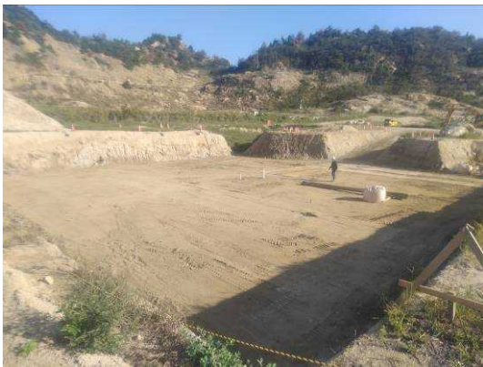
写真1 埋戻し後の状況（全景（北側から））
