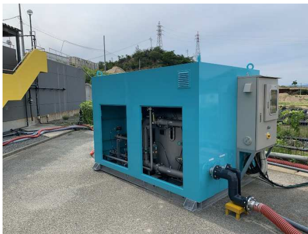
外観及び接続状況
