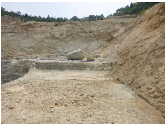
写真 11 完掘時の状況 (小区画⑨-9 (西側から))
