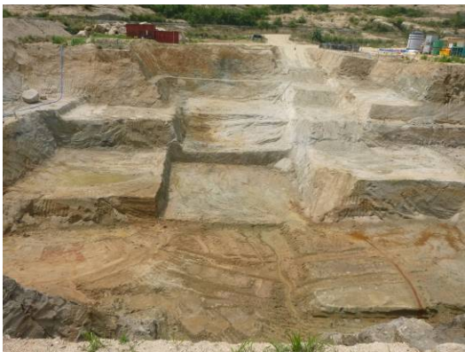
写真 1 土壌掘削の状況（全景（北側から））
