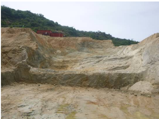
写真7 完掘時の状況 (小区画⑨-5 (南側から))
