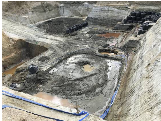
写真 1 8 水洗浄の状況 (静置状況)
