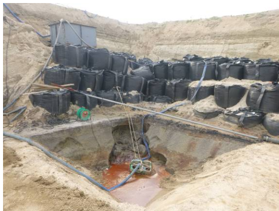
写真 1 5 区画⑬側からの湧水の対策状況 (埋戻し中)
