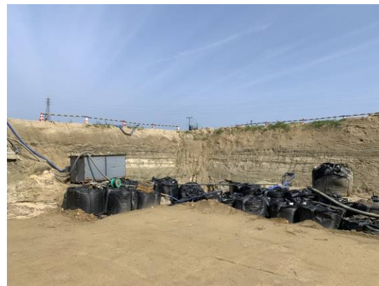
写真 1 6 区画⑬側からの湧水の対策状況 (埋戻し後)
