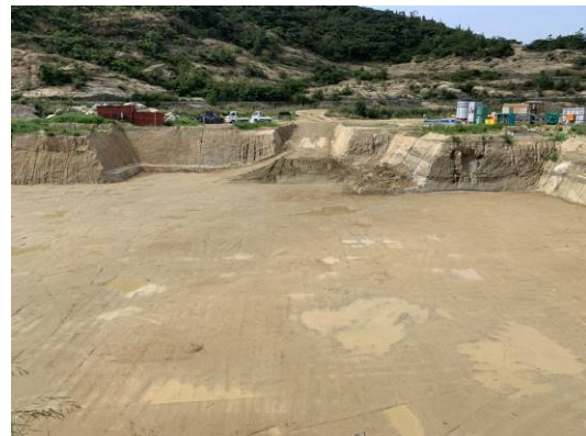
写真 2 埋戻し後の状況（全景（北側から））
