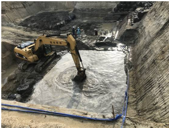
写真 1 7 水洗浄の状況 (攪拌状況)
