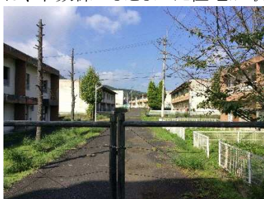
(国分寺団地用途廃止部分)
