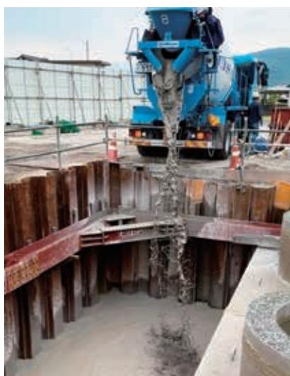
■環境への負担の少ない循環型社会を形成していくためには、廃棄物等の発生抑制やリサイクルを推進するなど、環境への負荷を低減していくことが重要です。このため、環境配慮の観点から建設汚泥や戻りコンから骨材を回収して製造した「再生コンクリート」や回収後に残った泥水を脱水してできた「ソイルクリーン」を路床材に有効利用するなど、リサイクル製品を安定して供給することが可能なシステムを構築しております。
