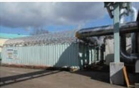
■熱源や試薬などを用いない微生物を使った生物脱臭装置を開発、実用化し、自社の工場やグループ会社の施設に設置し、環境負荷の低減に努めています。
