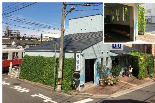
高松琴平電気鉄道(株) 今橋駅 様 (高松市)
