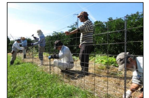
柵設置の様子
