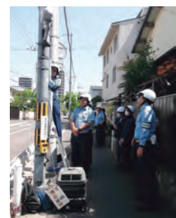
発動発電機による信号復旧訓練
