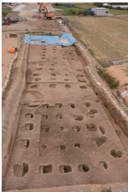
南北に軸を揃え並ぶ掘立柱建物(北から)
