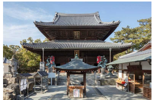
文化財を活用した地域づくり促進事業 (重要文化財 善通寺金堂 防災施設整備)
