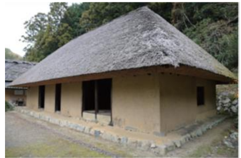
文化財を活用した地域づくり促進事業 (重要文化財 細川家住宅 保存修理)
