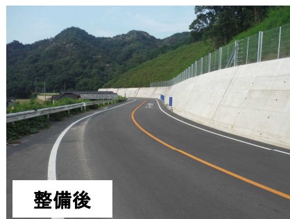
県道津田川島線(大川工区) 法面整備による落石等の防止対策
