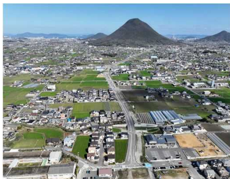
国道438号(飯山バイパス)
