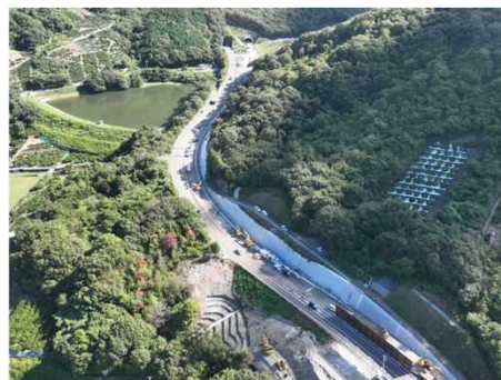
県道高松坂出線(五色台工区)
