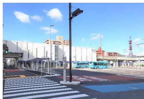
ことでん新駅(伏石駅) 駅前広場の整備
