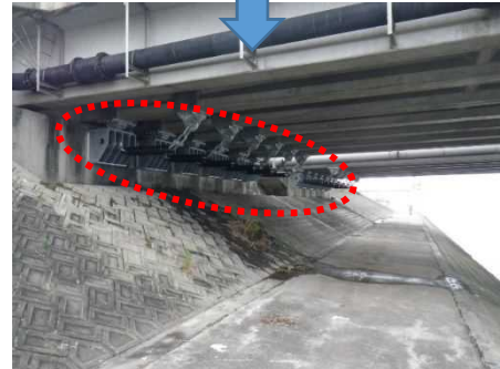
県道川津丸亀線(土器川大橋) 落橋防止装置による耐震化対策
