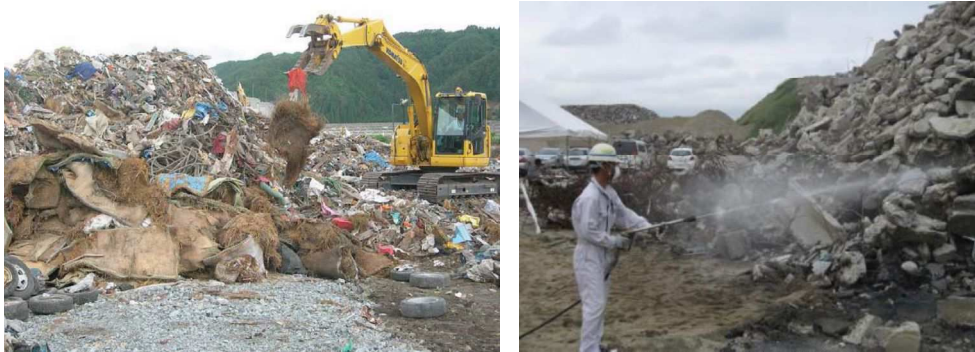
(左)7月4日 小本港 宮古からの災害廃棄物受け入れの様子
