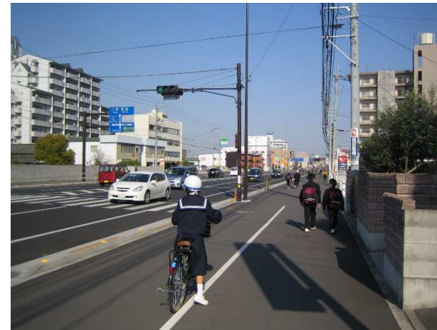
整備後の状況（本線）
