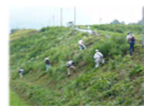
法面の共同草刈り作業
