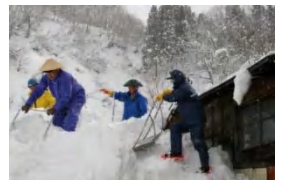
地域運営組織と連携した高齢者世帯の雪下ろし作業
