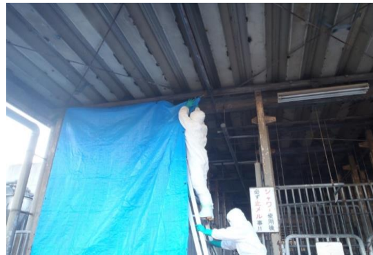
写真2 ブルーシート設置訓練
