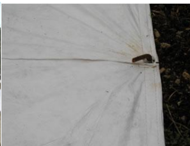
図2 ピンによる固定状況
