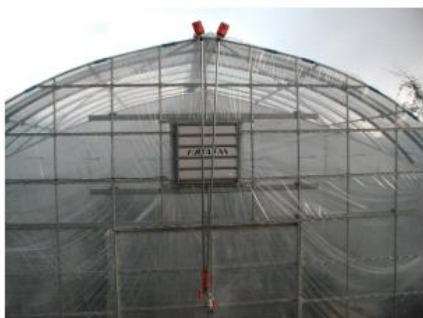
図2 巻き上げ器の設置状況
